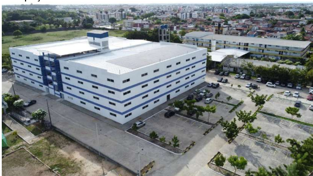
Ampliação do estacionamento e conclusão do novo Bloco.
